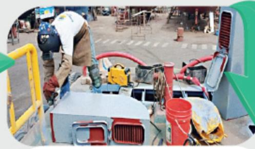
Trabajos de soldadura para remplazo de ductos de aspiración de sala de máquinas.
