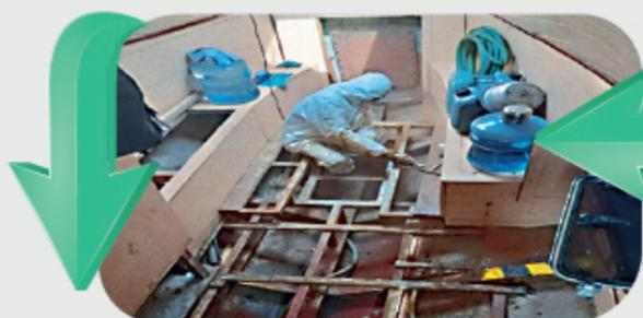
Vista del salón con el piso retirado para mantenimiento del plan y sistema de agua dulce y sanitario.
